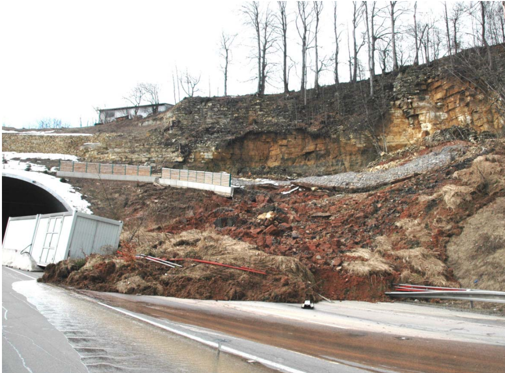
Obr. 16: Portál tunelu Hřebeč zavalený sesuvem v březnu 2006. Příklad významné dopravní infrastruktury, jejíž uzavření vždy působí výrazné dopravní komplikace (foto: Oldřich Krejčí, ČGS).
